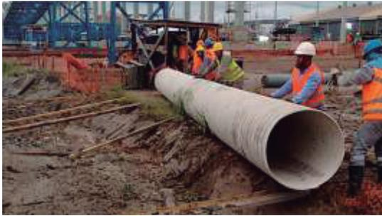
Para deslocamento do tubo pode-se utilizar também dispositivos apresentados nas fotos ao lado. Na prática, o tubo é envolvido por uma corda ou cinta, deslizando sobre caibros de madeira.
