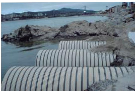
A tecnologia dos Tubos de PVC Estruturado **BRLOC** provém de um processo de enrolamento helicoidal de um perfil de PVC estruturado. Possui também características externas estruturadas e internas muito lisas. Essas tubulações plásticas possuem uma grande variedade de diâmetros.
