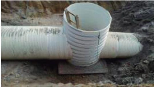
A união dos tubos das bocas de lobo à galeria, ou qualquer outra interligação entre os tubos **BRLOC**, poderá ser executada através de poços de visita ou caixas de inspeção ou diretamente na rede se forem de PVC. Paralelamente, a interligação com trechos construídos com outros materiais, como por exemplo, a redes preexistentes em concreto, também deverá ser realizada através da execução de poços de visita.
