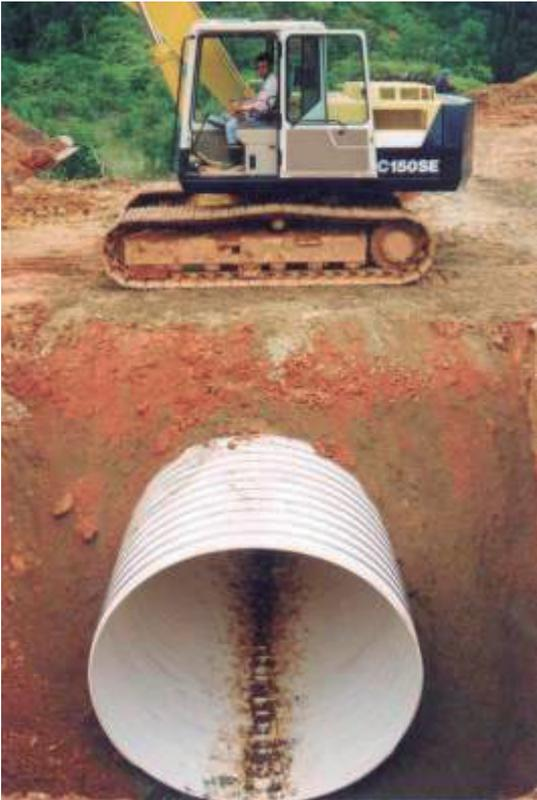
As solicitações que normalmente atuam sobre o sistema solo-tubo são aquelas devidas às cargas permanentes (peso da terra sobre o tubo, pressão hidrostática decorrente da eventual presença de lençol freático) e aquelas devidas às cargas acidentais (ação do tráfego de máquinas durante a obra tráfego normal de veículos na pista e de outras eventuais sobrecargas).
