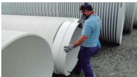
OBS: Esse sistema de acoplamento é utilizado em tubos de até 1200mm, o qual já é fornecido com a luva.
