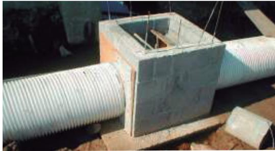
A conexão dos tubos **BRLOC** a poços de visita é realizada através da fixação da tubulação no poço de visita em concreto ou alvenaria por meio de argamassa de cimento e areia, ou do concreto no processo de execução da caixa. A própria disposição externa do tubo favorece a plena ancoragem da argamassa na superfície externa do tubo, o que garante, inclusive, uma estanqueidade à conexão executada.
