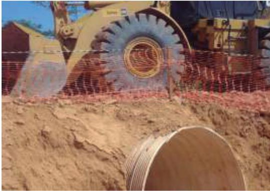
A deformação diametral  $\frac{\Delta y}{D}$ , obtida pela fórmula de Iowa-modificada, deve ser inferior à deformação máxima admitida, geralmente de 7,5%. Lembramos que este valor limite advém da deformação diametral a partir da qual pode ocorrer reversão de curvatura da tubulação (30%), dividida por um coeficiente de segurança igual a 4.
