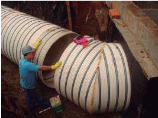
A **PERFIL ENGENHARIA**, fornece, mediante consulta prévia, uma variada gama de conexões segmentadas nos diâmetros de 160 mm até 3,00 m - produzidas a partir de tubos **BRLOC** - tais como: Joelhos (nos mais diversos graus), Tee, reduções, junções (concêntrica e excêntrica), inspeções, etc.
